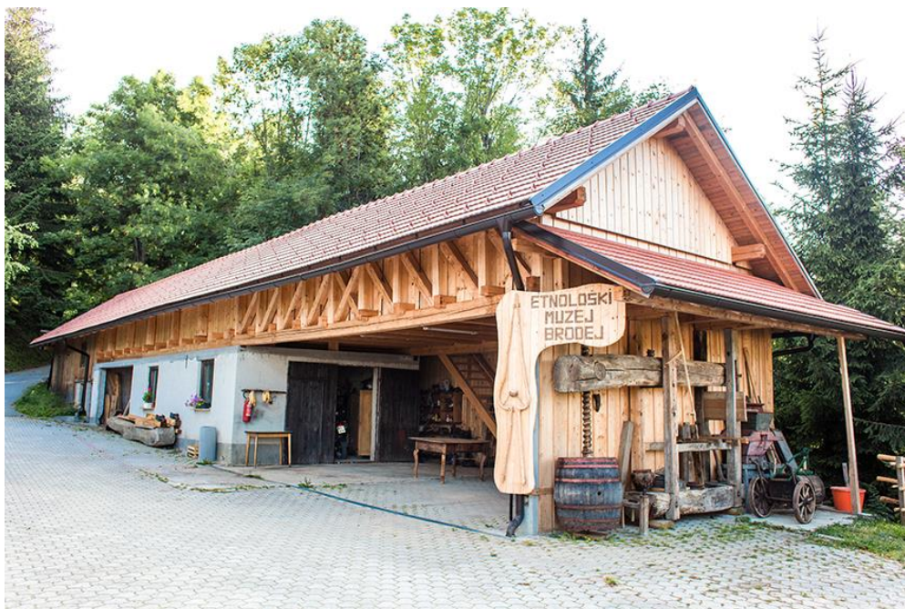
Foto 4 Stavba Etnološkega muzeja Brodej. Vir: Lipov list
